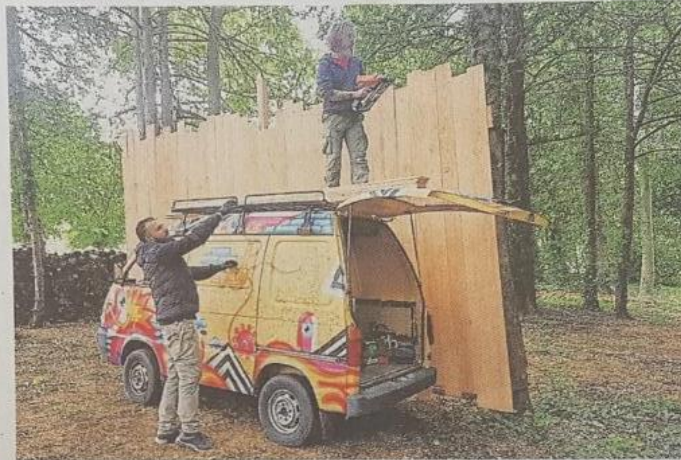
Les œuvres sont en cours d'installation dans le parc du Château de Môh.
